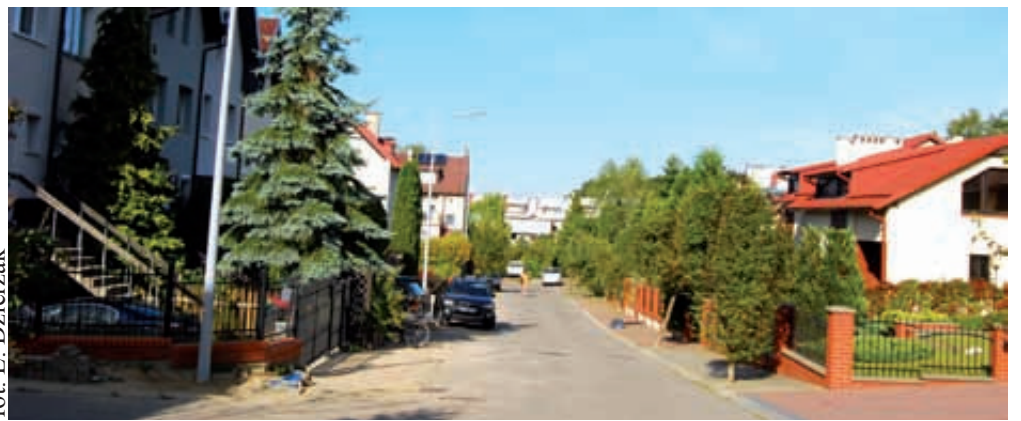
Lampy już stoją na ul. Głogowej
